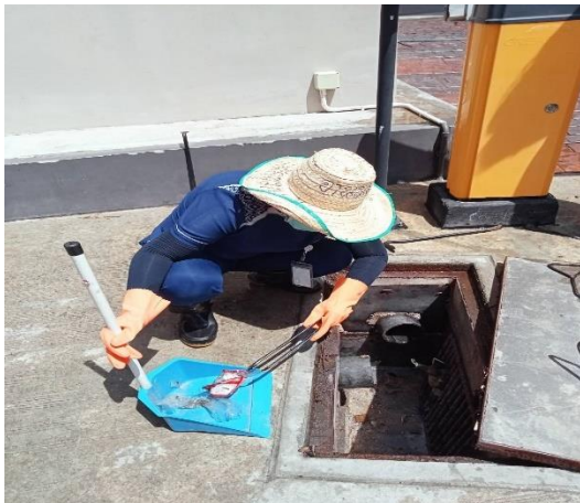
รูปที่ 2-25 การทำความสะอาดและตรวจสอบสิ่งอุดตัน หรือกีดขวางทางน้ำไหล
