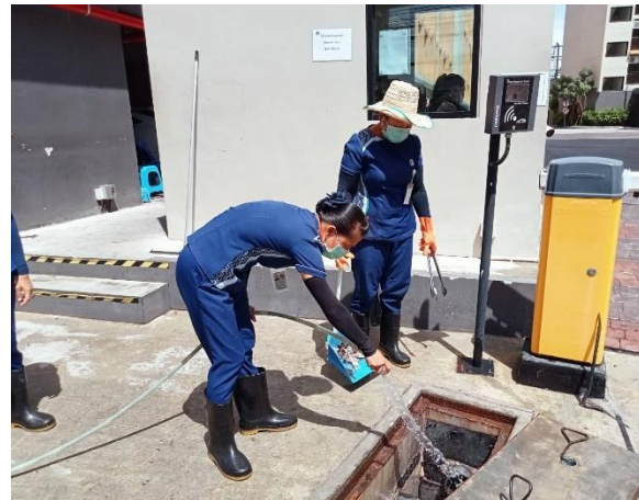
รูปที่ 2-26 ทำความสะอาดตะแกรงดักมูลฝอย
