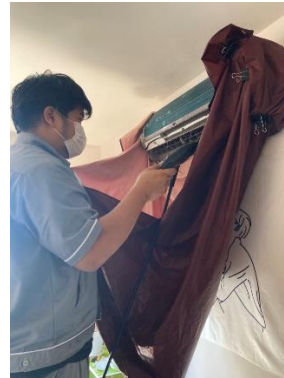
รูปที่ 2-36 การล้างเครื่องปรับอากาศ
