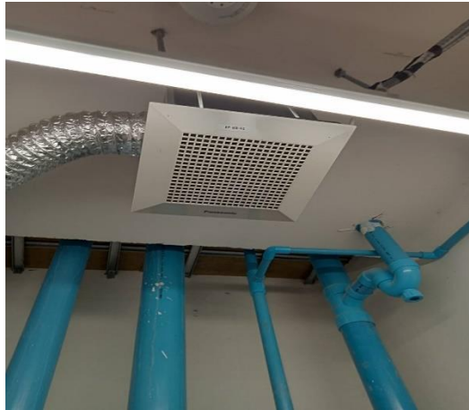
รูปที่ 2-24 พัฒนาระบายอากาศในห้องพักรวมมูลฝอย
