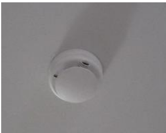
เครื่องตรวจจับควัน/เครื่องตรวจจับความร้อน
