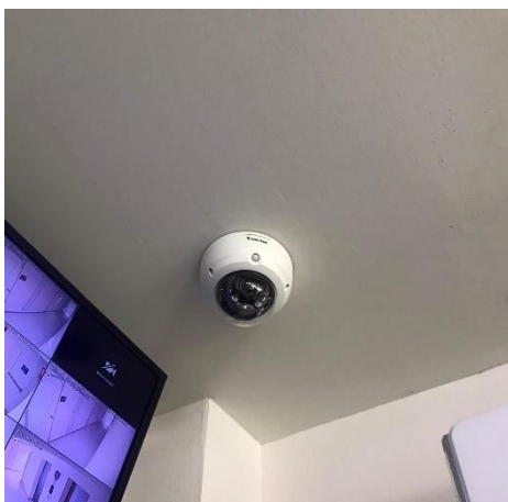
รูปที่ 2-34 ระบบโทรทัศน์วงจรปิด (CCTV System)
